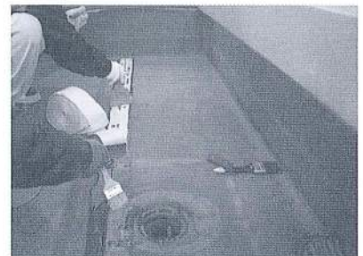
ガラスクロステープにゴムエースLCを含浸させ、接合部を補強する
